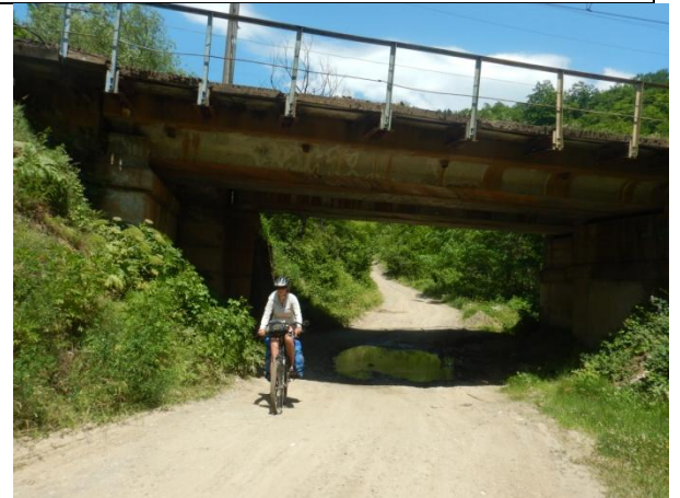
Пересечение Ж/Д путей под мостом
